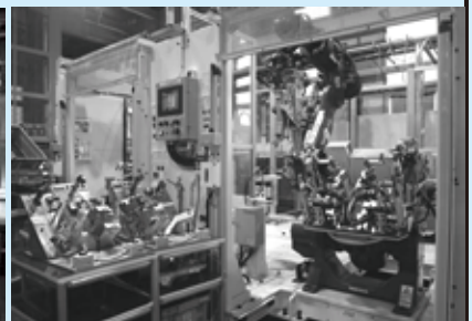
▲溶接ロボット
