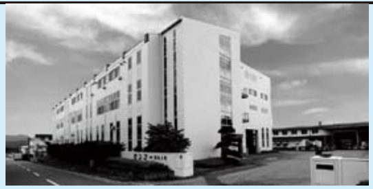
▲ 堀金工場全景
