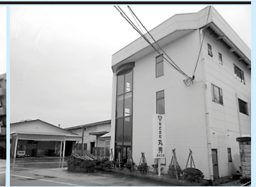
▲ 長井第2工場事務所棟
