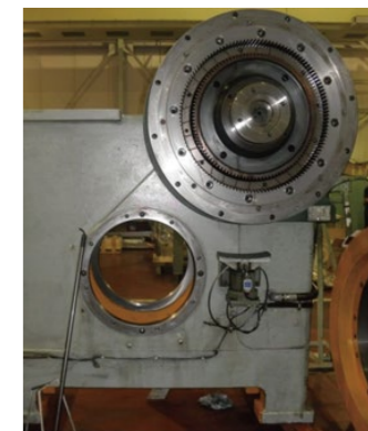
オーバーホール工事時のトルクユニット (クラッチ側)
