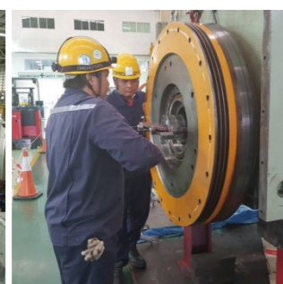
300 トンプレス機の オーバーホール
