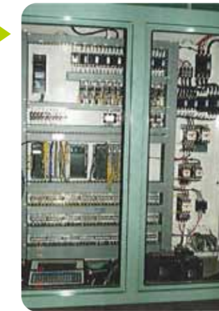
新型制御盤 (プログラマブル・コントローラー搭載)
