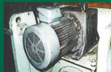
施工前 変速機付モータ
