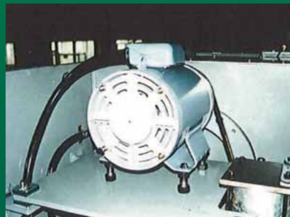
施工後 インバータモータ
