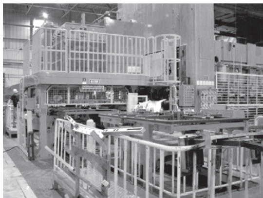
写真1 改造後の材料供給装置
