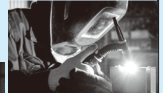
▲ 溶接 (アルゴン2台、自動機4台)
